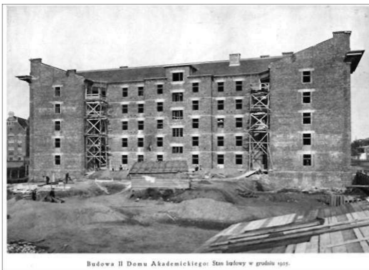
Budowa II Domu Akademickiego: Sto łóżowy w grudniu 1955.
