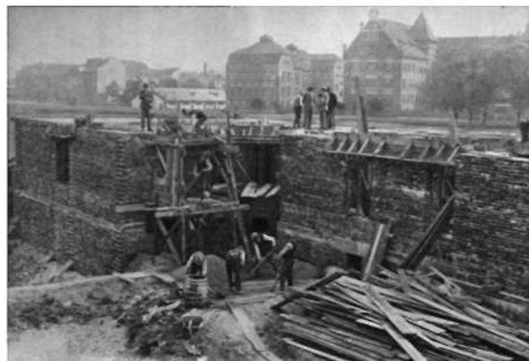
Budowa II Domu Akademickiego, maj 1925 r. (z Archiwum UJ)
